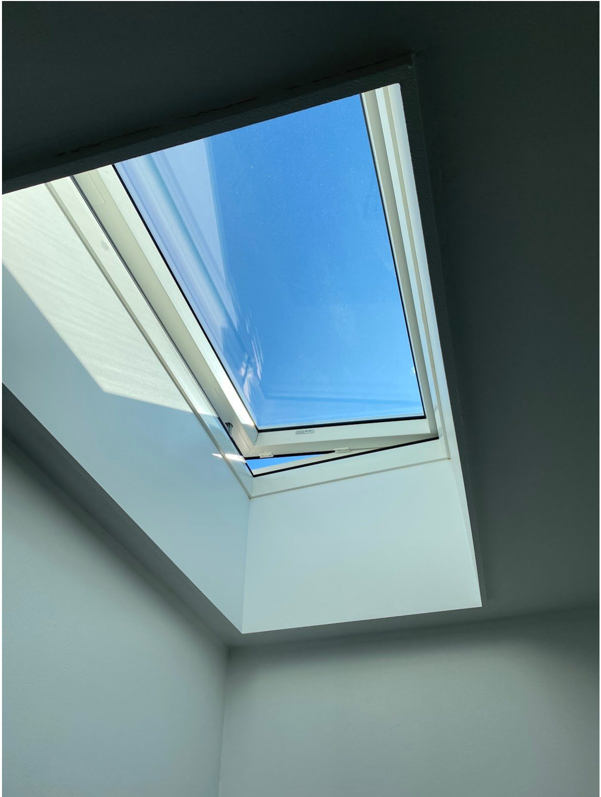
Vindue set indefra, på eksisterende indfatning - Vinduet er fuldt åbent
