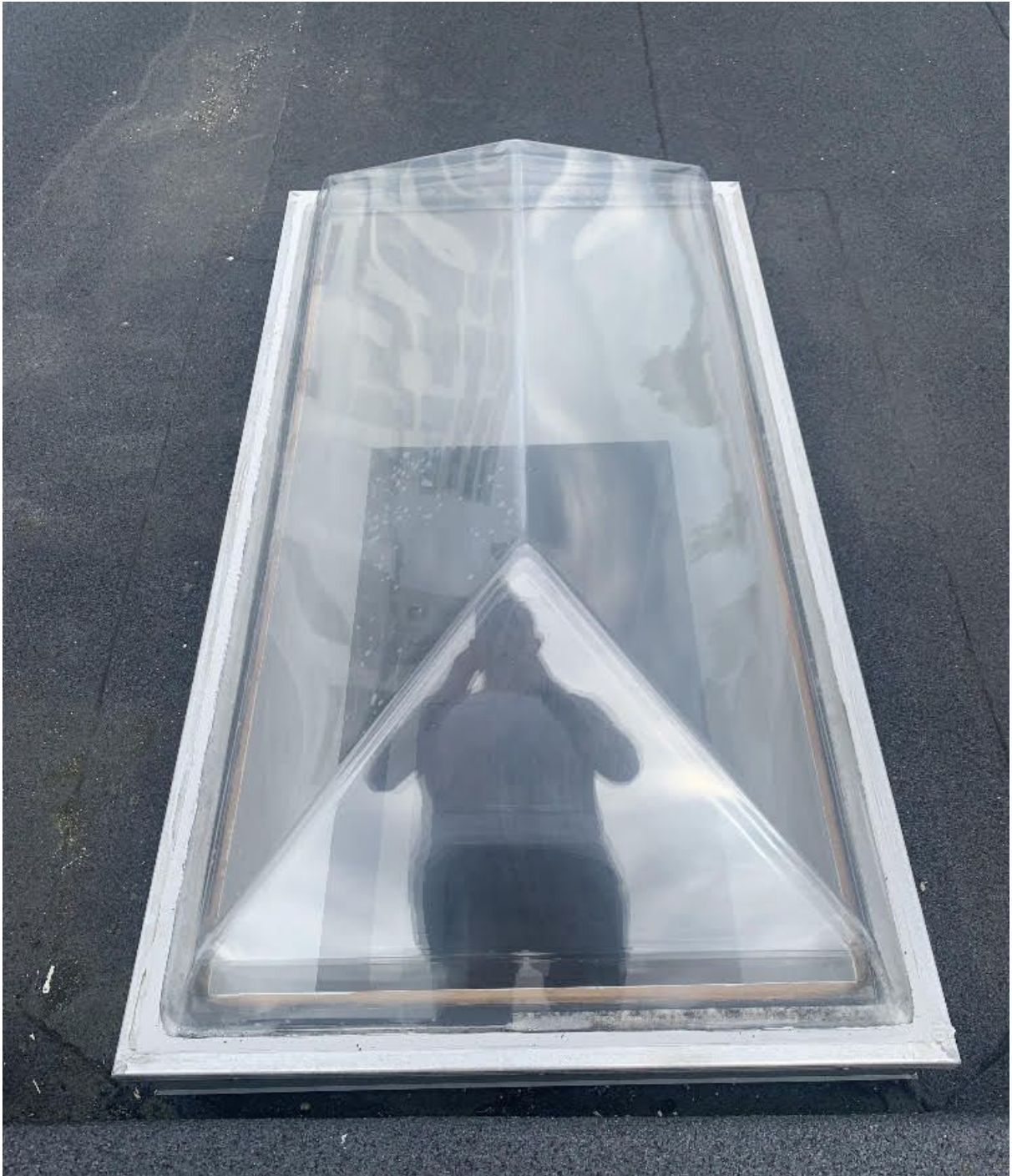
Billed viser genmonteret vindue, hvor der er fuget mellem aluramme og akrylrude
