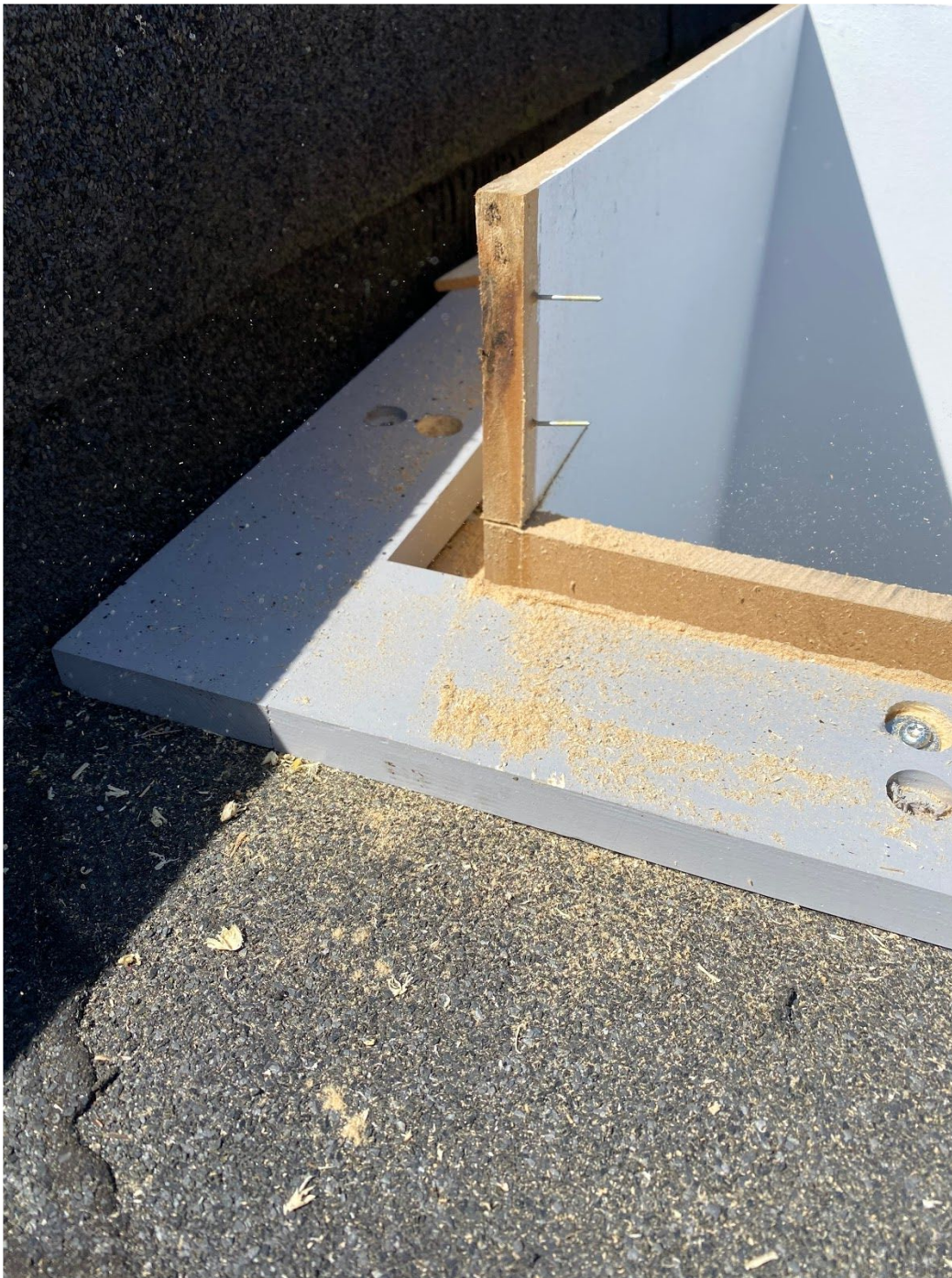
Billede viser demonteret ramme, og tilpasning af lysning til nyt vindue. Bemærk fugtskader fra gl. vindue som kunne fjernes. En stor del af indfatningen kan fjernes, og erstattes af isoleret ramme på vindue. Rammen indeholder 3 pakninger og vandnæse
