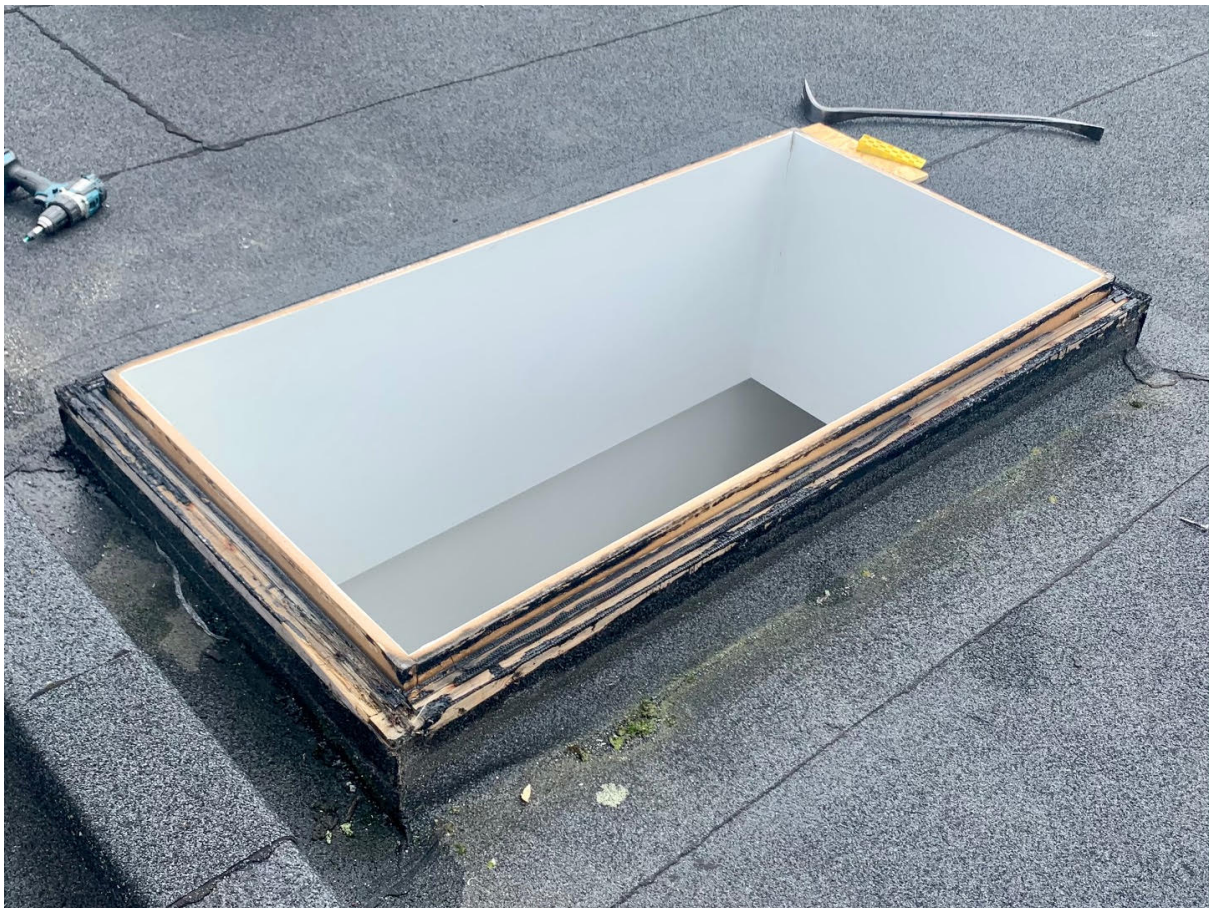
Billede viser afmonteret ovenlys
